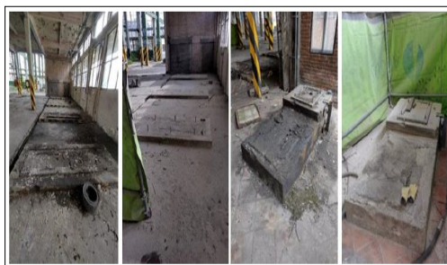
Ilustración No. 2. Estructuras sometidas a proceso de Sandblasting
